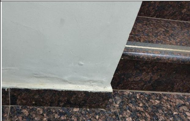
Umidade próximo a escada piso inferior
