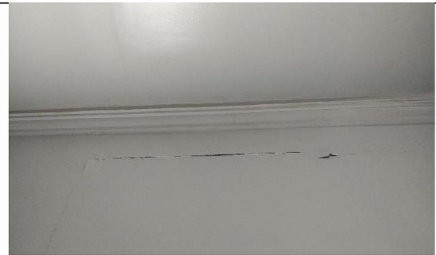
Trincas do forro na sala de licitação
