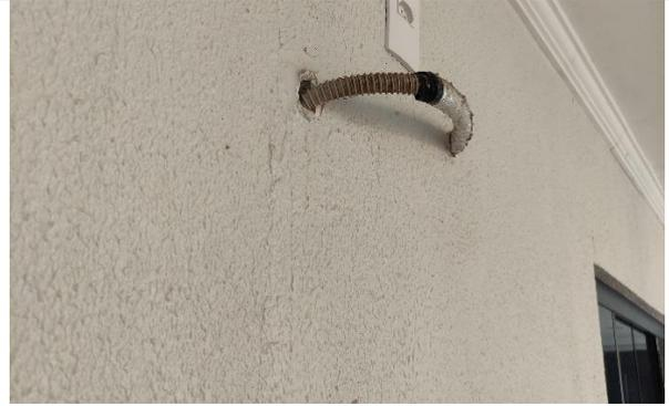
Dreno exposto não embutido em parede janela sobre jardim direito, da evaporadora da recepção
