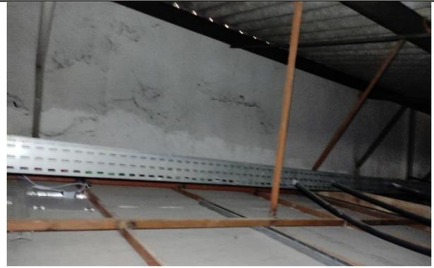
Estrutura de montante do forro feito de forma inadequada nos ambientes dos fundos.
