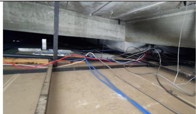
Uso de chapas de gesso acartonado e fixações do forro no piso inferior
