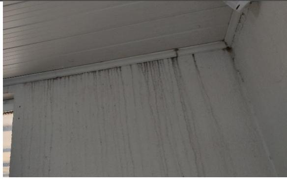
Mancha de infiltração próximo da telha parcialmente solta na sala de arquivo
