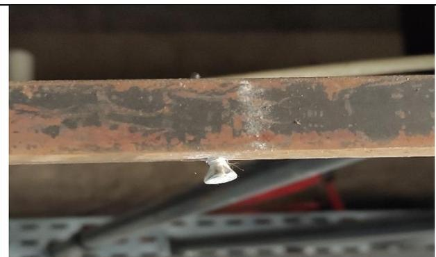
Chapa cimentícia se soltou dos parafusos de fixação
