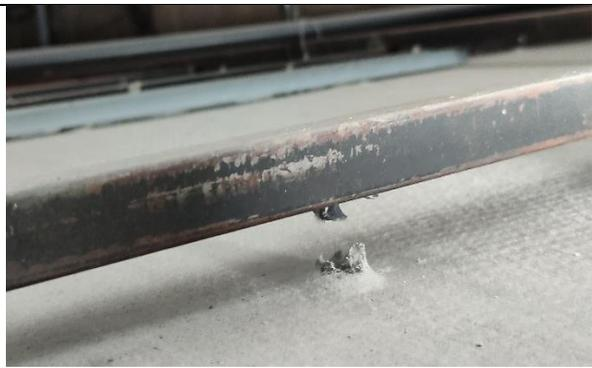
Parafusos de fixação soltando das chapas
