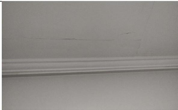
Trincas do forro na sala CPD
