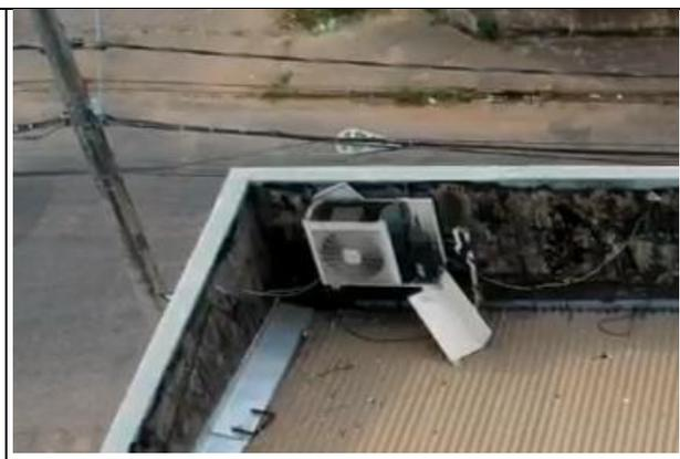
Conferir limpeza e condições do dreno das condensadoras do CPD, com umidades
