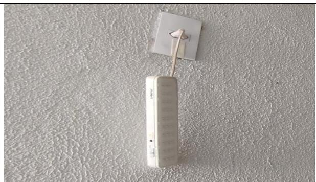
Tomada iluminação d emergência desligada escada acesso ao 2º piso
