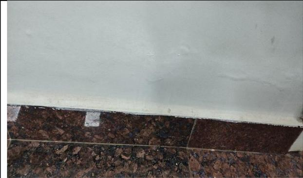
Umidade no piso inferior proveniente da fundação
