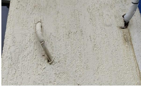
Tampa de proteção dos sistema elétricos da condensadora solta, cobertura sobre sala de reunião
